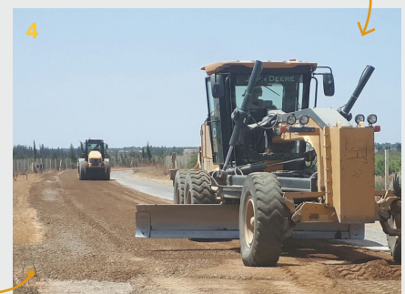
6 Nivellement et compactage
