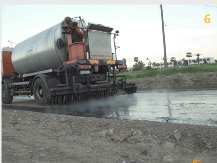
4 Mise en oeuvre de la couche de protection
