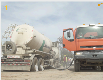
1 Dépotage du LHR de la citerne vers l'épandeur
