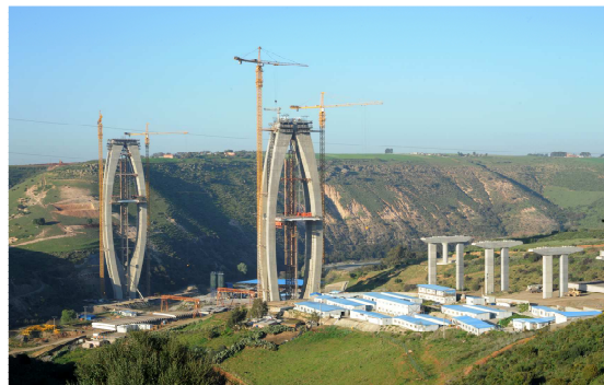
Pont à haubans - Voie de contournement de Rabat
