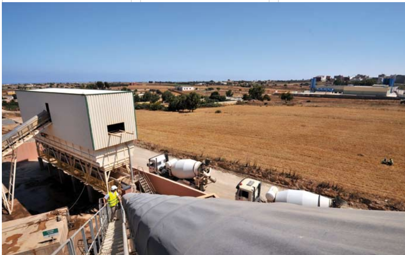
Photothèque Lafarge : Centrale à béton - Dar Bouazza
