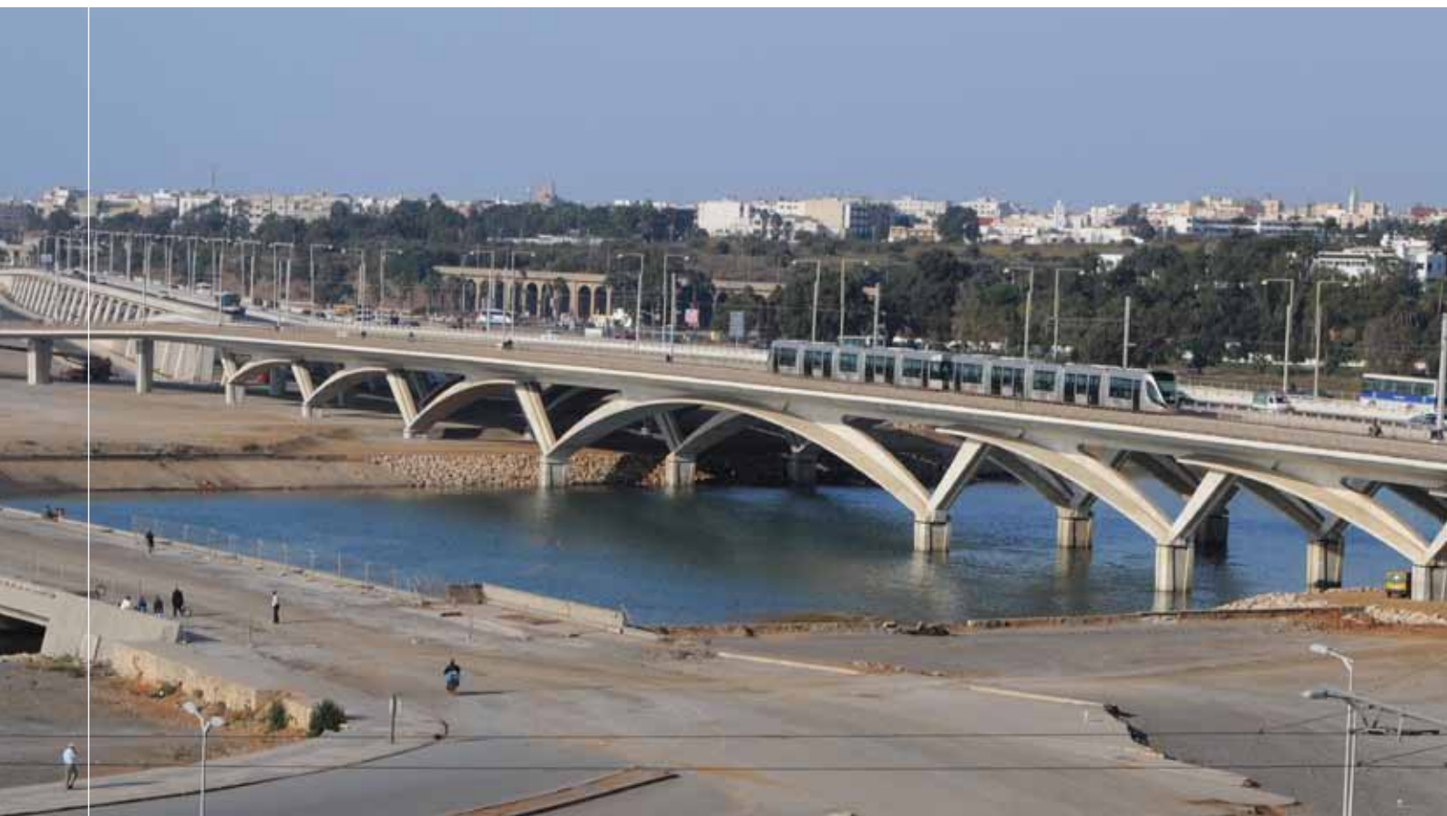
Photothèque Lafarge Maroc « Vue du Pont Hassan II – Rabat »
