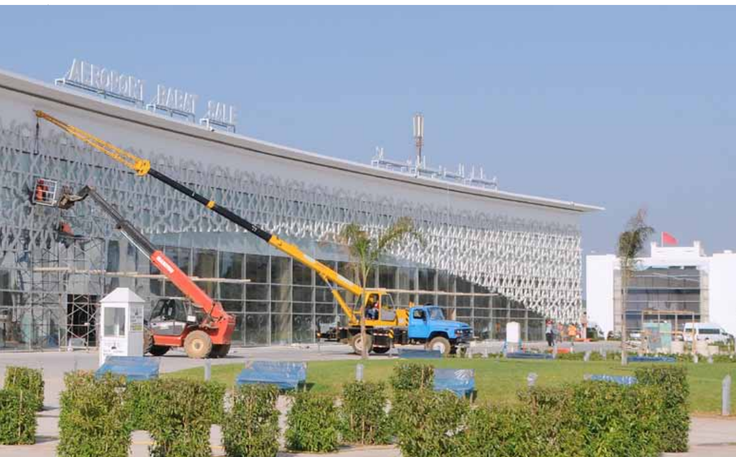
Photothèque Lafarge Maroc « Moucharabieh Ductal® de l'aéroport de Rabat-Salé, fabriquée par Bearch »
