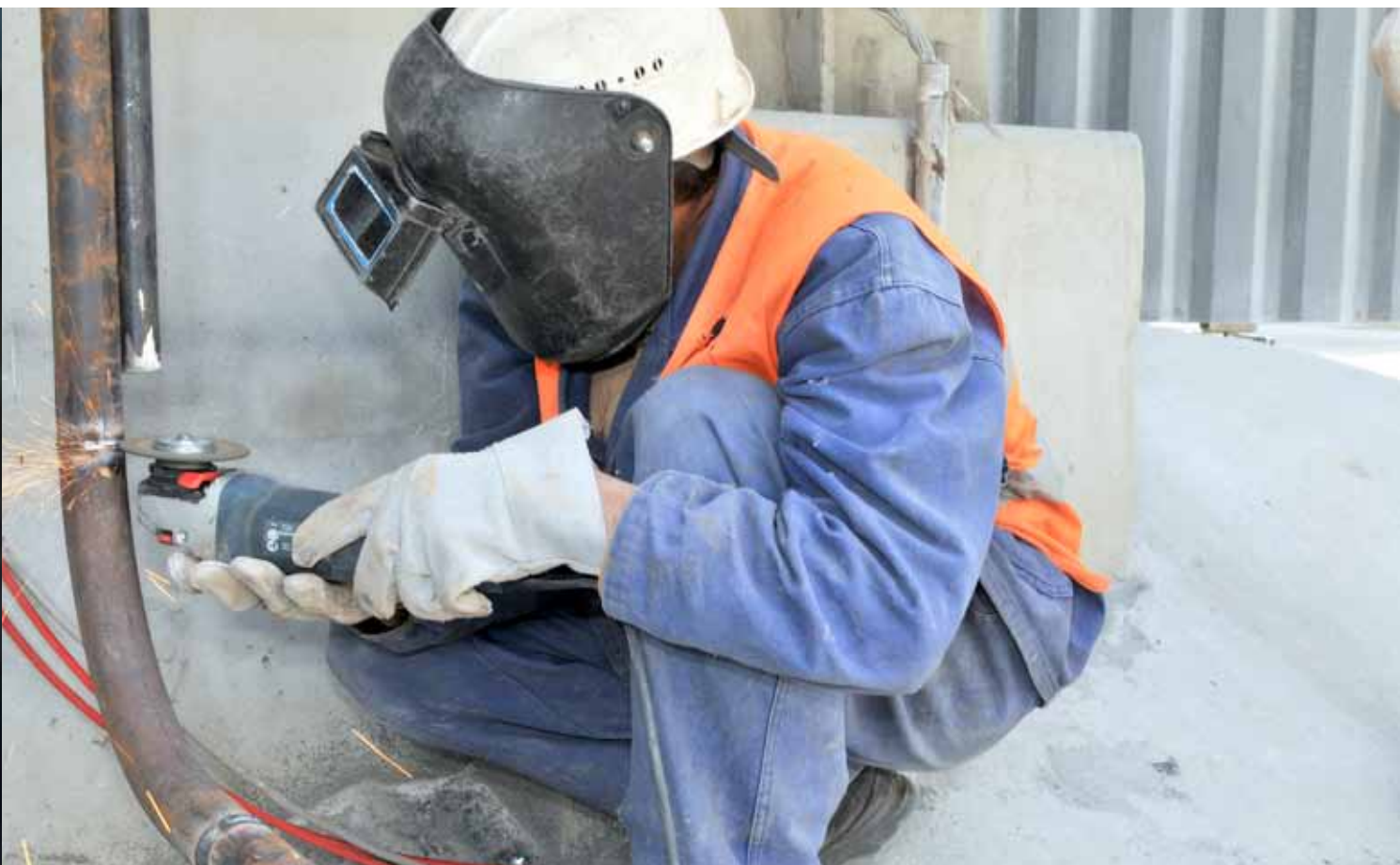
Photothèque Lafarge Maroc « Opération de soudure à l'usine »
