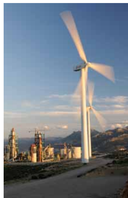
Photothèque Lafarge Maroc « Vue de l'usine de Tétouan »
