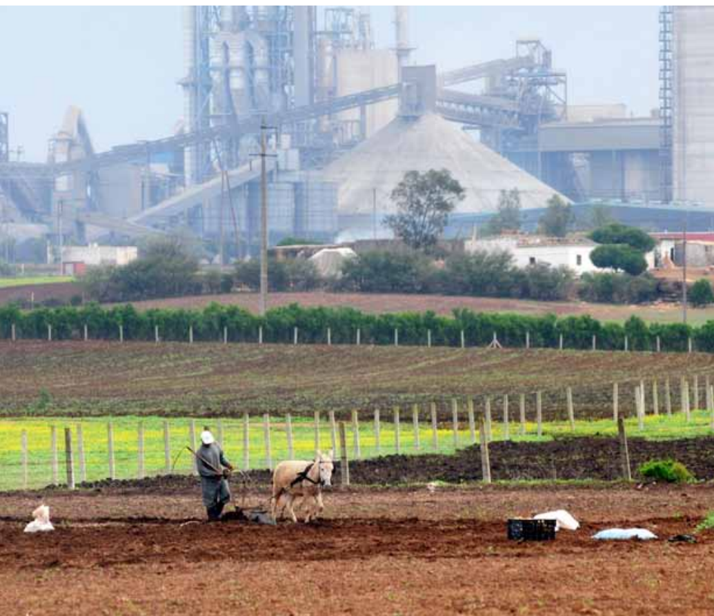
Phototèque Lafarge Maroc « Vue de l'usine de Bouskoura »
