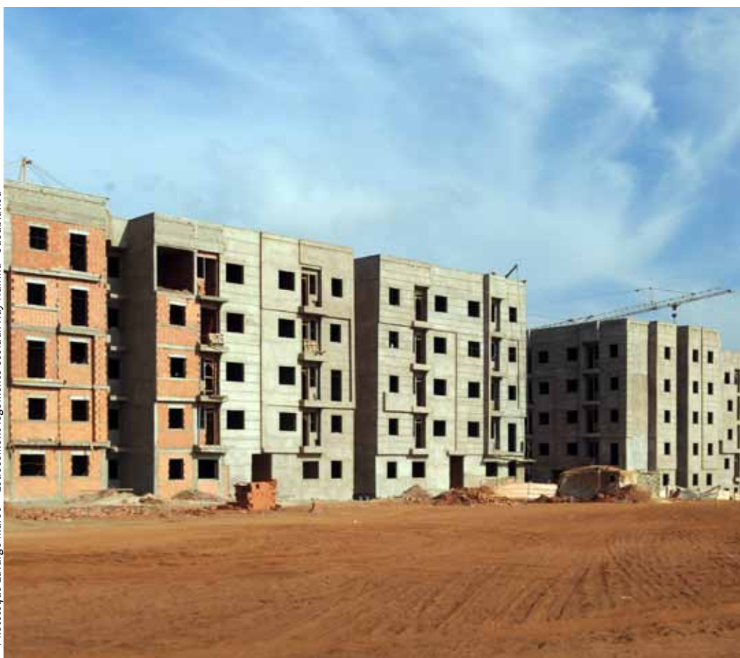
Photothèque Lafarge Maroc « Lotissement logements sociaux Hay Rahma - Casablanca »
