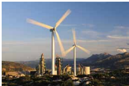
Usine et parc éolien de Tétouan
