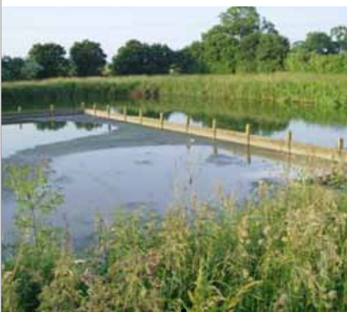
« Bassin de décantation des eaux »
